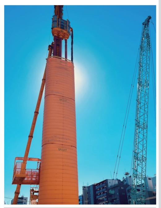
杭打ち作業時の汚泥飛散防止に貢献し安全管理対策の向上に導入実績多数 耐候性抜群の PVC ターポリンを採用、規格品以外の特注サイズも製作可能
